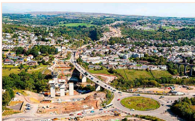
Imagen de la autovía A465 ejecutada por FCC en Gales.
