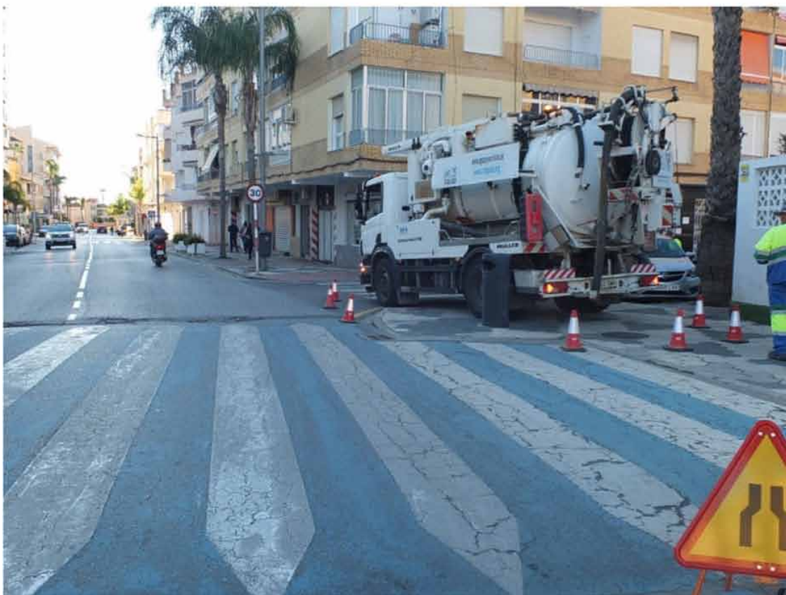
Limpieza de imbornales por Aguas y Servicios de la Costa Tropical
