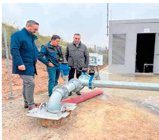
Inauguración de una obra de mejora del Ciclo Integral del Agua en la Mancomunidad del Temple. IDEAL
