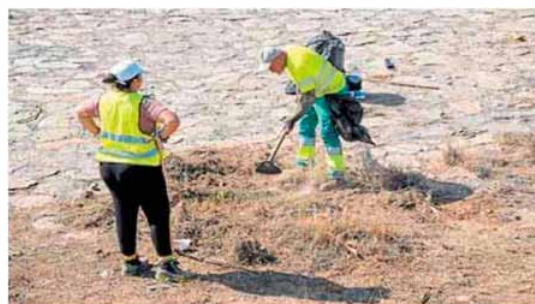
La acción permite retirar lodos y vegetación en el barranco. A. SUÁREZ
